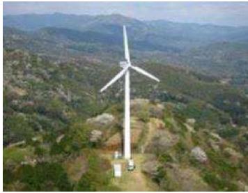
南伊豆風力発電所 ミーコン/400kW/2基
