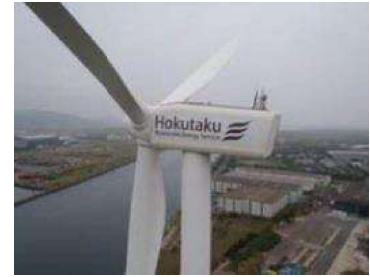
北九州ひびき風力発電所 ヴェスタスV80/2000kW/1基
