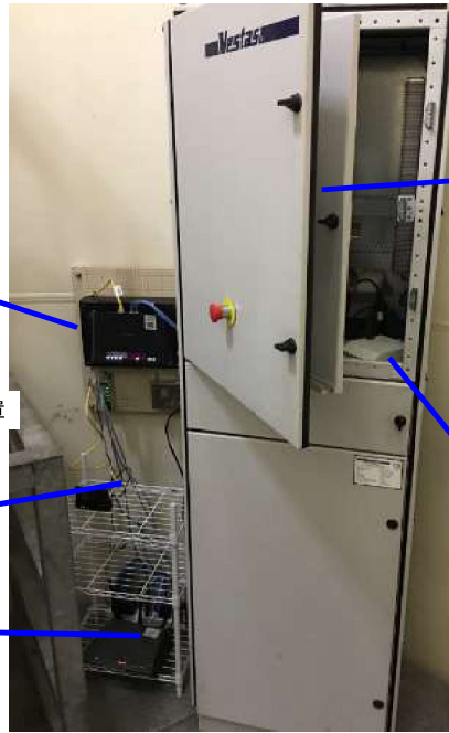
Ciscoファイアウォール & NTT光モデム
