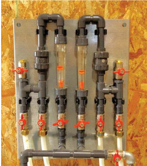
生物脱硫装置 (空気流入制御バルブ)
