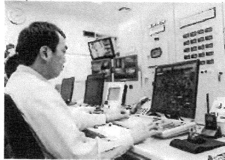
発電所全体の運転を制御、監視します。コンピューターにて自動制御されます。
