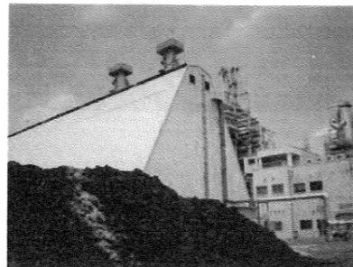
燃料チップの貯蔵用サイロです。貯蔵量は 5200 m<sup>3</sup>で、約 3 日分です。万一のため火災報知機と大型消火器の他に散水（消火）設備を設置しています。サイロ底部から発電出力に応じた燃料をボイラーへ供給します。
