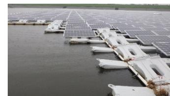
写真① パネル・フロートの撤去跡
