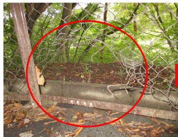
常駐設備員によるフェンス破損箇所修繕
