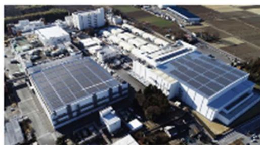
図1 栃木工場の太陽光発電設備（生産棟の屋上の様子）
