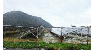
発電施設の外観
