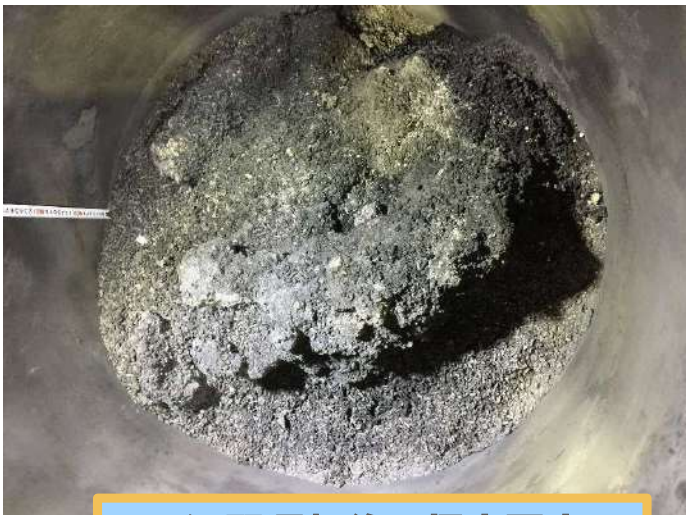
2週間運転後の炉内写真
