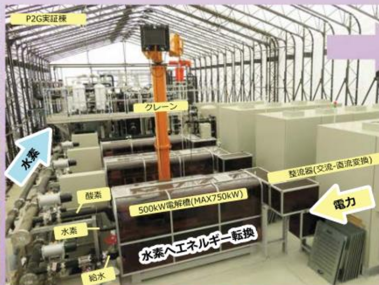
大型電解槽(スタック)評価設備 750kW×3列
