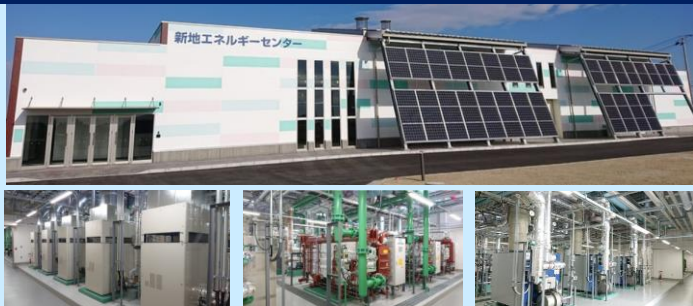
CGS（ジョイントシステム） 排熱回収型吸収冷温水機 温水ボイラー
